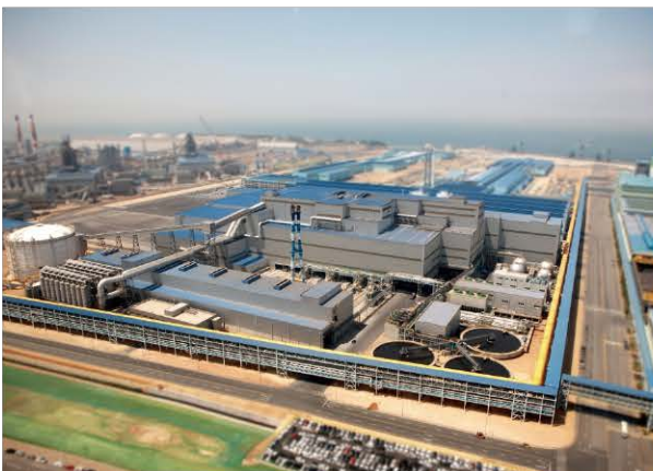
일관제철소 건설공사 중 제강설비 토목공사 2007.07~2010.06
