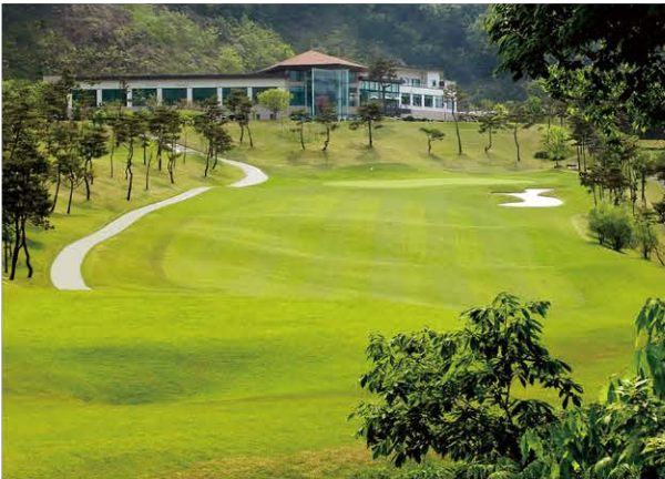
프린세스GC 조성공사 (18HOLE) 2005.08~2007.12
