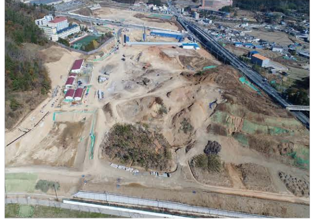
부산장안지구 택지개발사업(2단계) 조성공사 2019.06~2021.02
