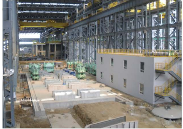
일관제철소 건설공사 중 후판공장 토목공사 2008.03~2010.09
