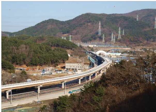
부산지하철 3호선 2단계 328공구 토목공사 2005.11~2010.12
