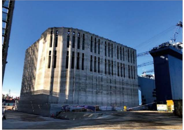
울산신항 남방파제 축조공사 중 케이슨제작공사 2020.05~2022.03
