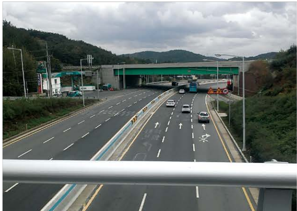
동면-장안간 연결도로 건설공사(2공구) 2004.08~2011.11
