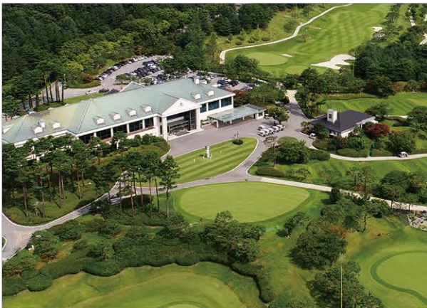
춘천라디나CC 시설공사 (9HOLE) 1988.08~1989.12
