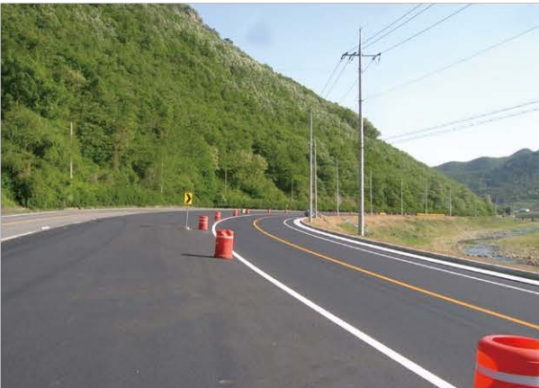
청도-경산간 도로4차로 확장공사 2004.12~2015.01
