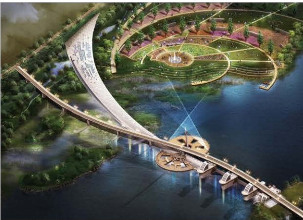
낙동강살리기23공구 사업 토공 및 구조물공사 2009.11~2013.06
