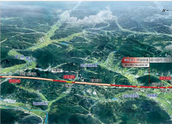
도담-영천 복선전철 9공구 토공 및 구조물 2구간 2017.05~2022.12
