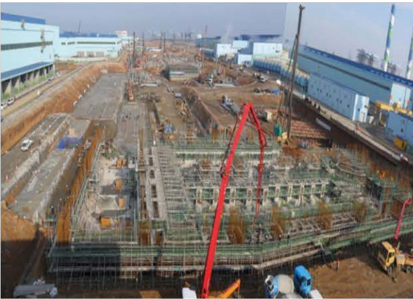
일관제철소 3기 건설 후판공장2 토공 및 흠막이공사 2011.08~2013.12
