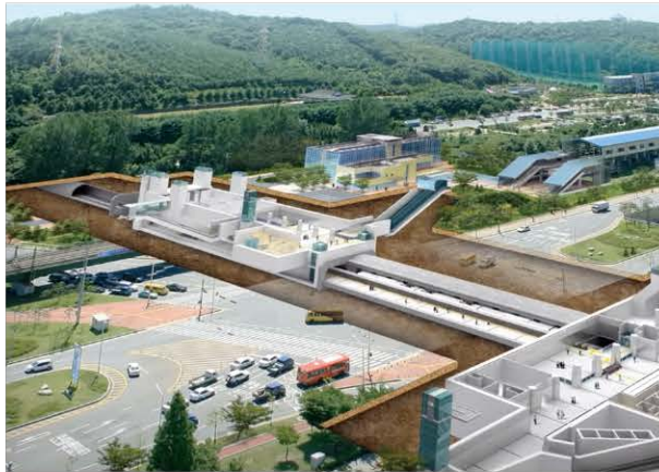
소사원시복선전철 4공구 노반공사 4-2구간 2012.08~2018.06
