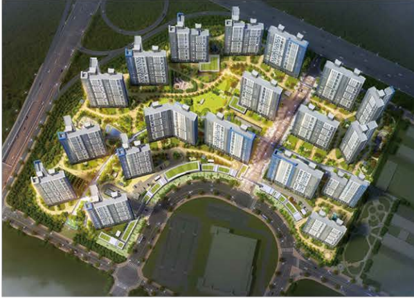
이천중리 택지개발사업 조성공사 2021.06~2022.12
