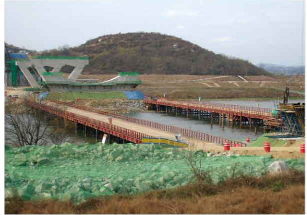
행정중심복합도시 미호천1교 토공 및 구조물공사 2010.10~2015.02
