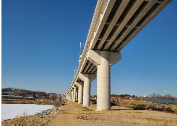
서해선 복선전철 9공구 토공 및 구조물공사(3구간) 2018.02~2021.06
