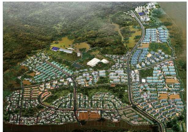
용인동백지구 택지개발 사업 조성공사 (1공구) 2002.10~2006.04
