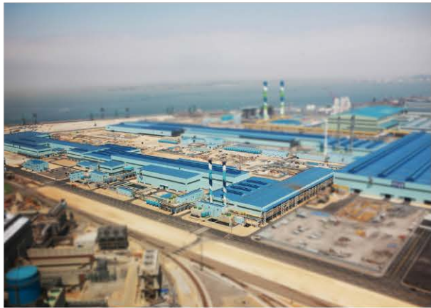
일관제철소 3기 건설 토목공사 중 연주공장 2011.05~2013.12
