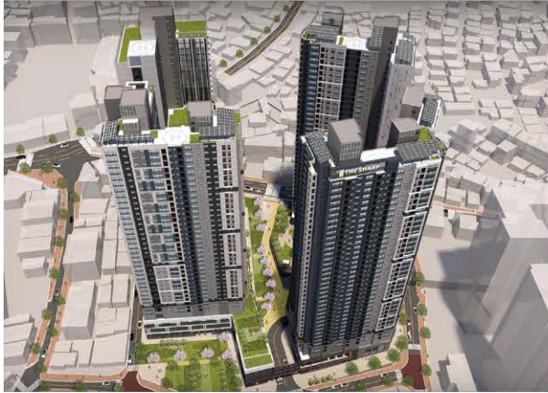
천호4축진구역 도시환경정비사업(시공) 토공사 2021.12~2024.12
