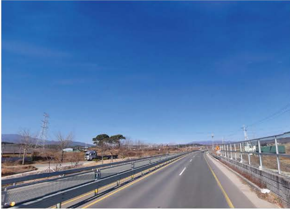
와촌-청통간 도로4차로 확포장공사 2013.05~2016.12
