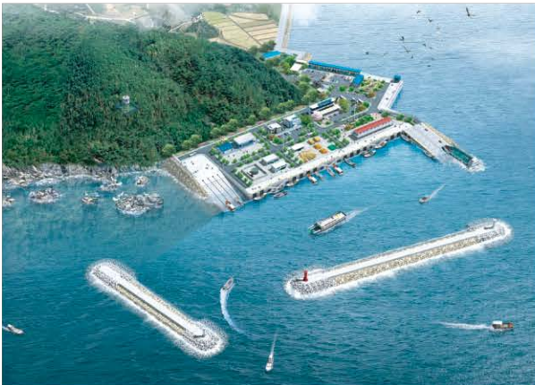
어유정항 정비공사 중 방파제 및 접안 시설 축조공사 2007.10~2016.02
