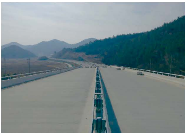
화양-나진간 지방도 확포장공사 및 흙막이공사 2013.11~2018.12
