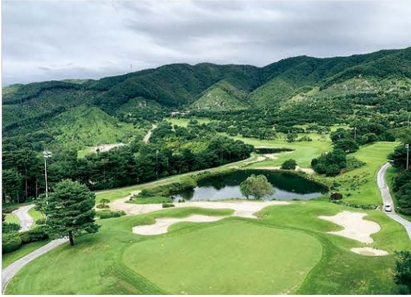
양평 TPC 클럽 건설공사 (27HOLE) 1994.09~2000.05
