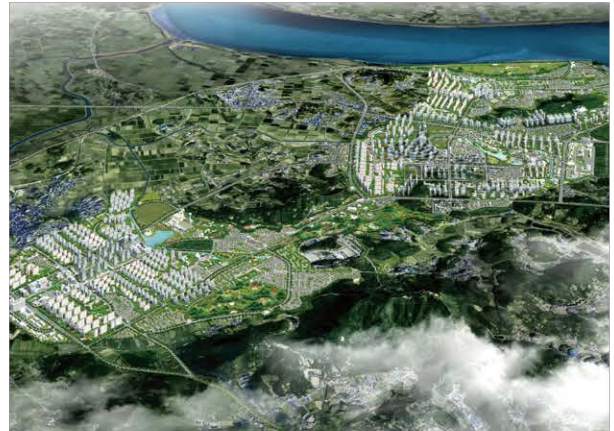
김포한강지구 택지개발사업 조성공사 (6공구) 2008.12~2014.12
