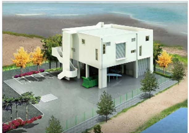
군산시 하수도정비 중점관리지역 침수예방사업 2015.11~2018.04
