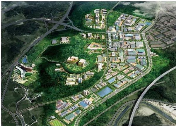
화장 전기공급시설 전력구공사 토공 및 가시설공사 2018.05~2021.05
