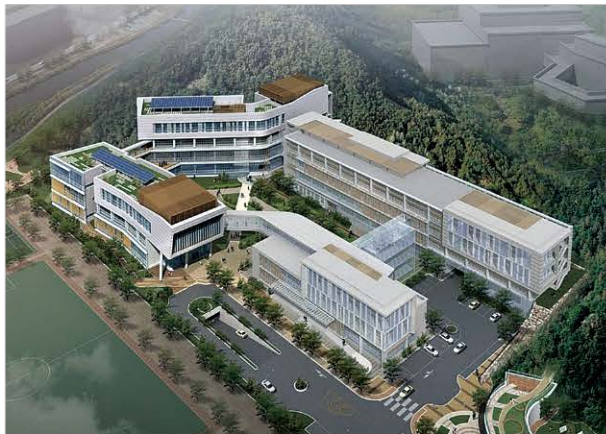
보건환경연구원 증축공사 토공 및 흠막이 공사 2009.07~2011.07
