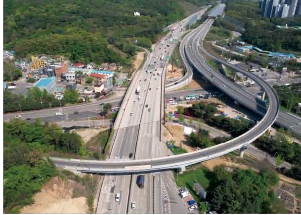
영동선 안산-북수원간 확장공사(2공구) 2012.04~2026.04
