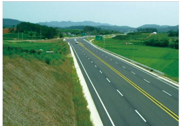
고창 상하-구시포간 지방도 확포장공사 2007.09~2012.05
